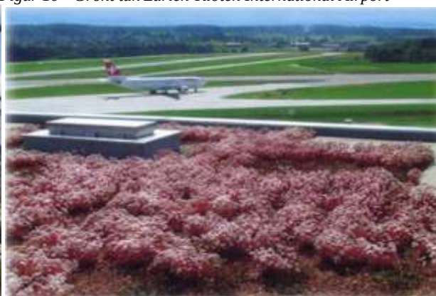
Figur 10 - Grönt tak Zürich-Kloten International Airport
