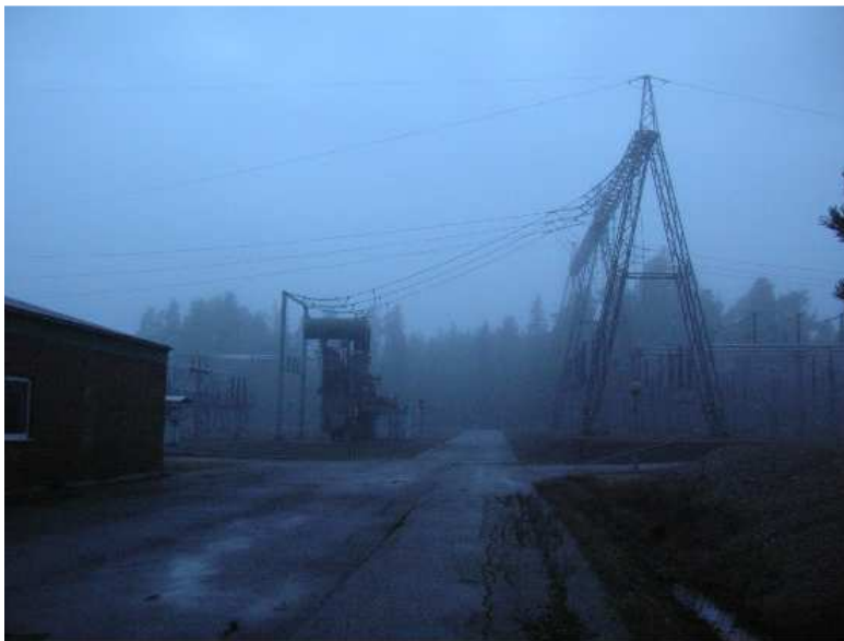
Bild 6. Ställverket vid Malsta där vindkraftparkens kabel ansluts. Foto: Roger Gustavsson.
