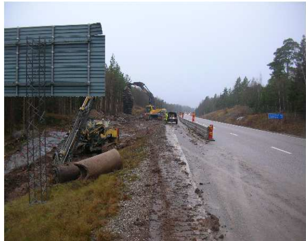
Bild 5. Kabeln kan med lätthet läggas längs E18 där arbete för nedgrävning av V/A-kablar redan skett. Foto: Anders Tranberg.
