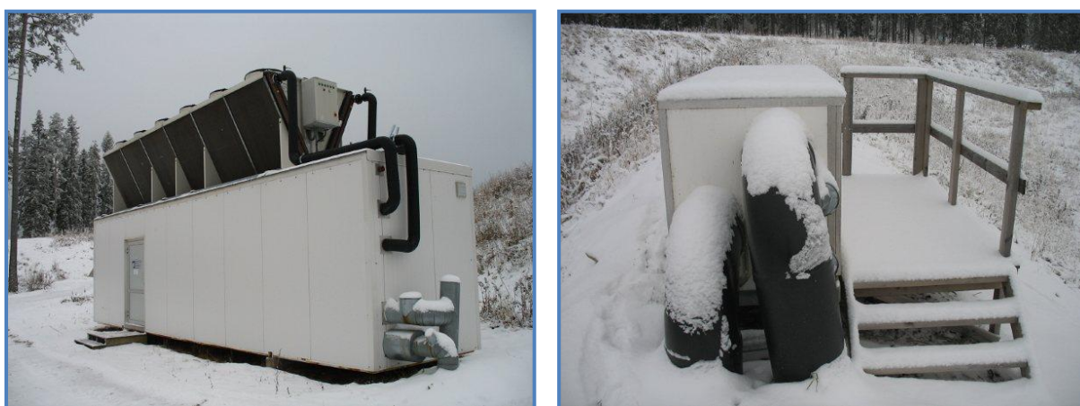
Figur 17: Kylanläggning och ventilationsanläggning för skidtunneln i Torsby. (Foto: Nicolas Orozco)
